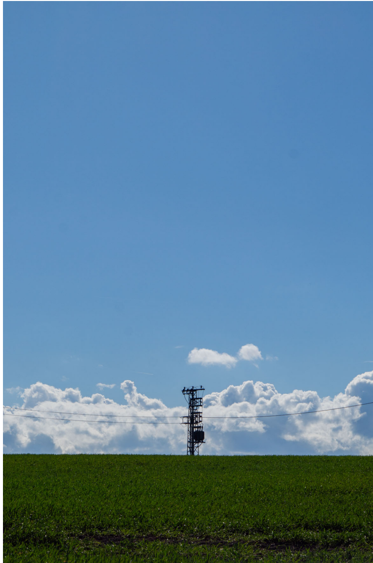
Campo con poste eléctrico, Namedy Feld mit Strommast, Namedy
