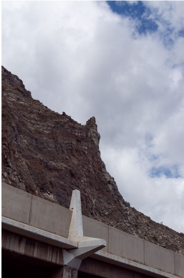
Carretera comarcal TF-11 frente a las estribaciones de los montes Anaga, Santa Cruz de Tenerife Landstraße TF-11 vor Ausläufern des Anaga Gebirges, Santa Cruz de Tenerife
